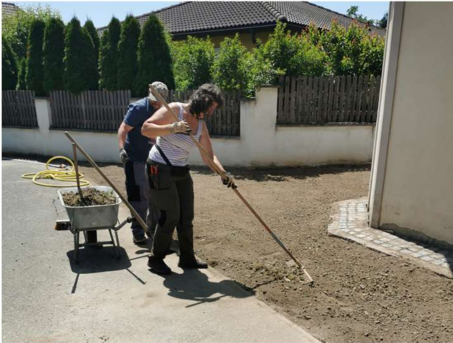
Vorbereitung der Fläche
